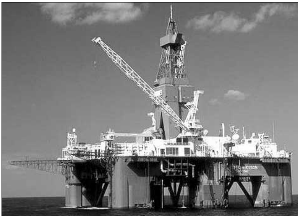
Eirikur Reyði er ein av heimsins størstu og best útjordu boripallum. Nú borar hann m.a. fyri føroyska oljufelagið Atlants Kolvetni. Mynd Atlantic Petroleum
