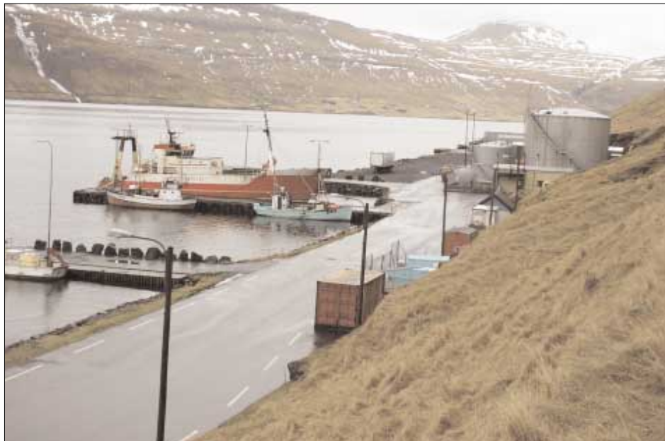
Thor fer at byggja fyrstingar- og goymslubygning sunnan fyri asfaltangarnar á havnarlagnum í Hósvík. Skipið við bryggjuna er North Star, sum Thor eigur
