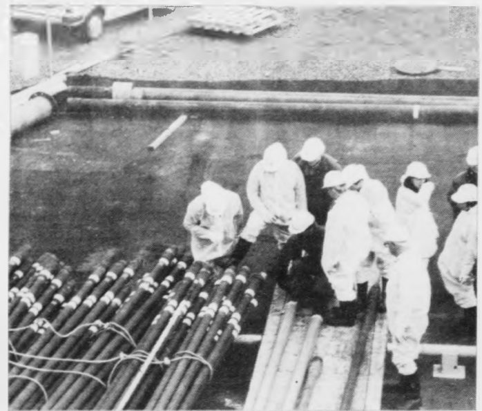
Nýggjborirør komu úr Aberdeen í vikuskiftinum, eftir at flestu av rørunum finga skaða í farnu viku, ta boristrongurin brotnaði og rørun datu niður í holið. Mynd jan
