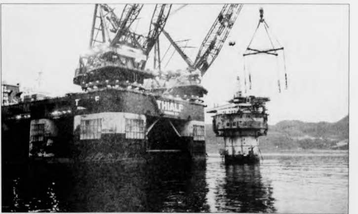
Kranaskipið -Trif- arbeidir við at taka óvasta partin av oljupallinum Brent Spar burtur. Nógv umstríddi parturin verður nu nýttur sum fundiment undir einari norðari bryggju
