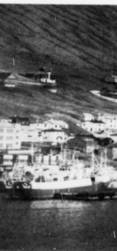
Tað kemur væl við, at nógv arbeiði er aftur á flakavirkinum í Vági. Tí í langa tív var at kalla púra oyðit í Suðuroyar býnum.
